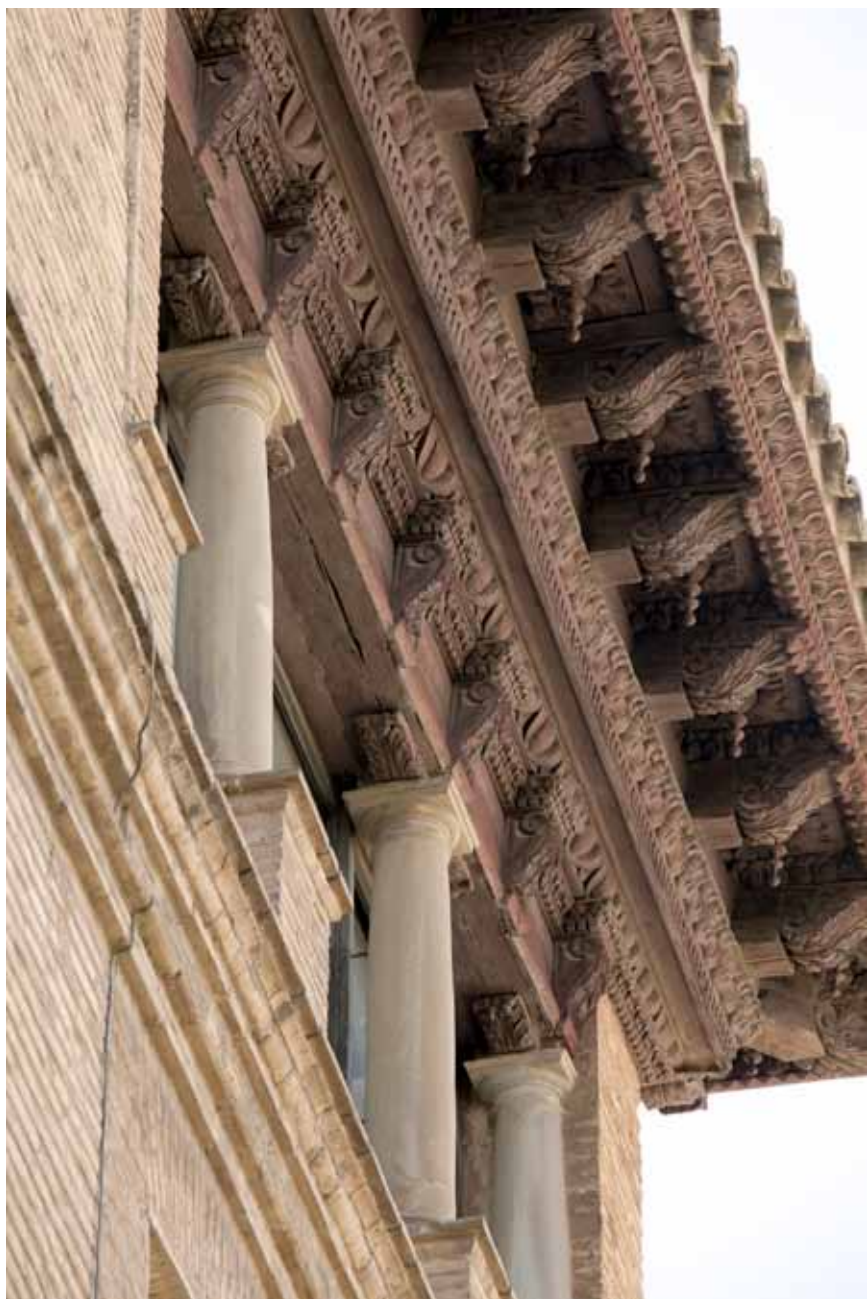
Galería de columnas y alero de madera del colegio de Santiago (1674-1677), construidos a imitación de los existentes en la casa consistorial desde un siglo antes. (Foto: Fernando Alvira Lizano)
