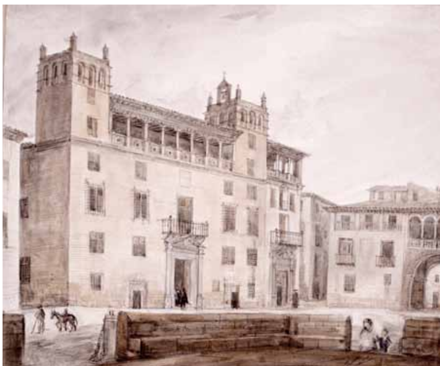
La plaza, sin fuente ni árboles y con dos elementos hoy desaparecidos: la lonja de piedra ante la catedral y el gran arco del fondo. Acuarela de Valentín Carderera. Siglo XIX. (Fundación Lázaro Galdiano)
