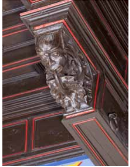
Ménsula de la jácena 8 (muro sur). Cabeza surgiendo de vegetación.
