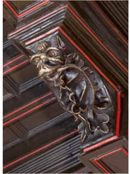
Ménsula de la jácena 6 (muro sur). Cabeza surgiendo de vegetación.
