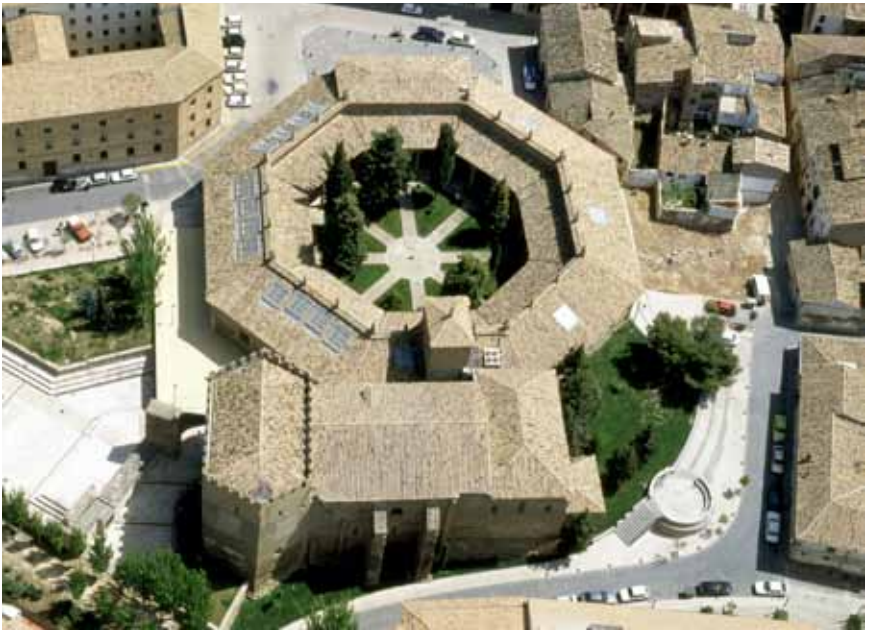
Vista aérea del palacio real: el torreón hexagonal con las salas de la Campana y de Doña Petronila, el paraninfo y la capilla de la Universidad —que aprovechan muros románicos— y el edificio octogonal de la Universidad. (Foto: Fernando Alvira Lizano)
