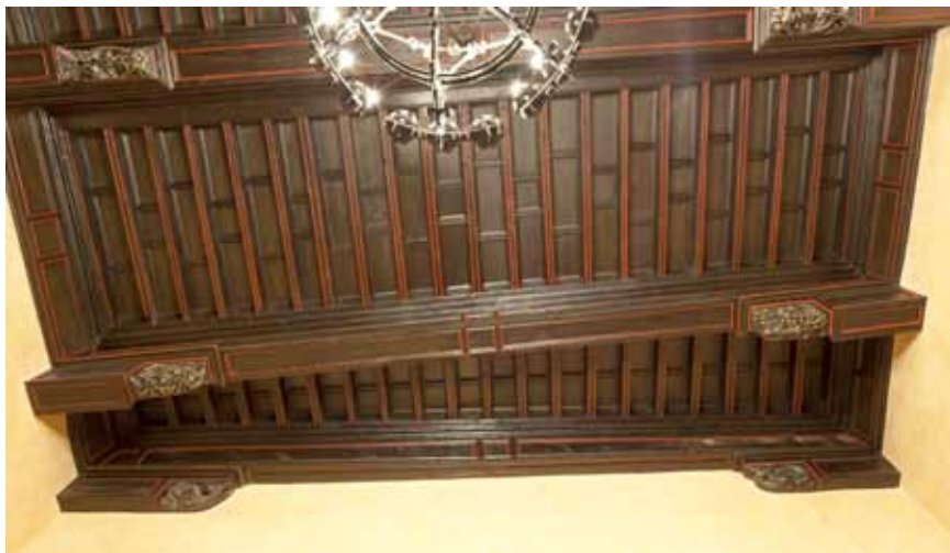
Última calle de la techumbre del salón del Justicia, de menor anchura que las demás y forma trapezoidal como resultado del derribo de la fachada original de las Casas de la Ciudad y de la construcción, algo retrasada, de la fachada actual. (Foto: Fernando Alvira Lizano)
