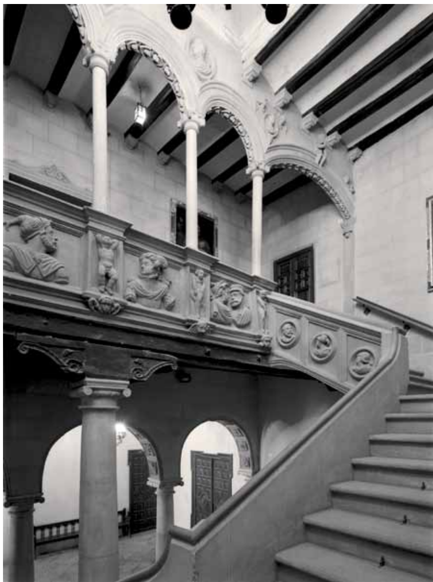
Los dos últimos tramos y el recibidor de la escalera. (Foto: Fernando Alvira Lizano)
