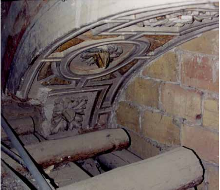
Capilla de las Casas de la Ciudad. Arco con decoración, posiblemente del siglo XVII, que cerraba la hornacina en la que estaba el retablo. (Fotos: María Pilar Felices Sa)
