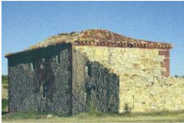
Foto 2. Antigua puerta principal, convertida en ventana, de la masada de la Ermita del Torrejón (Orihuela).
